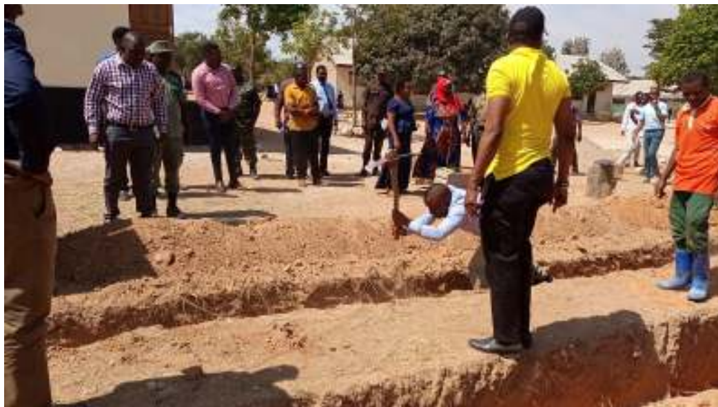
Dso Wilaya ya Manyoni Mpegwa Mwakasendo akichimba msingi
