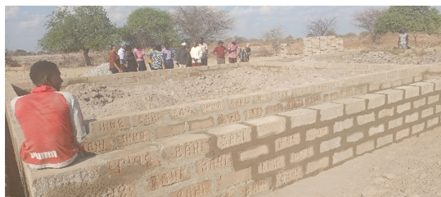
Ujenzi wa madarasa shule shikizi waraka kintinku
