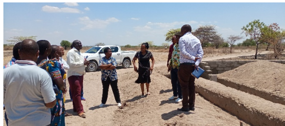
Shule ya sekondari ngaiti ujenzi ukiendelea
